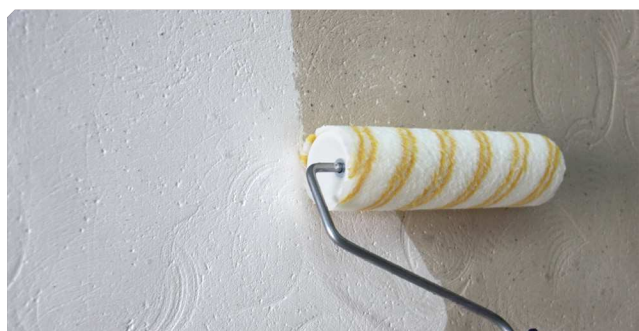
■ Imprimación del soporte con FIJAPREN AL DISOLVENTE
